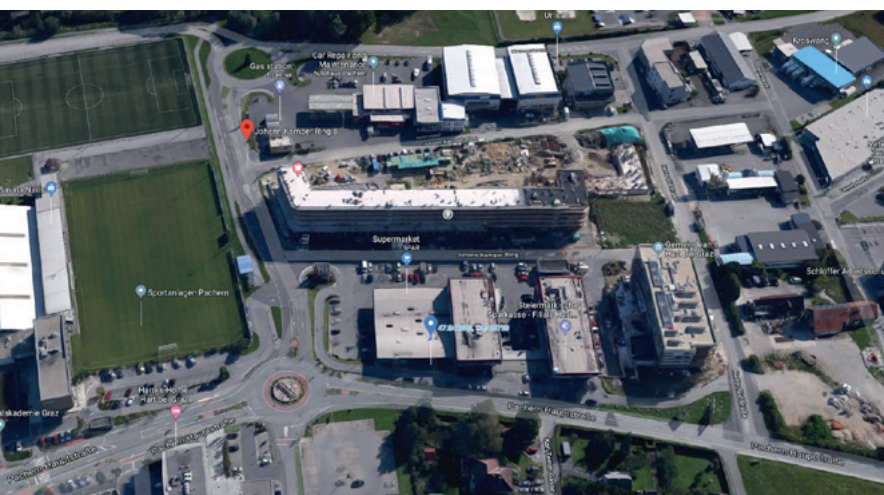
Abbildung 5: Neubauprojekt am GWS Wohnen Hart (Google Maps, 2018)
