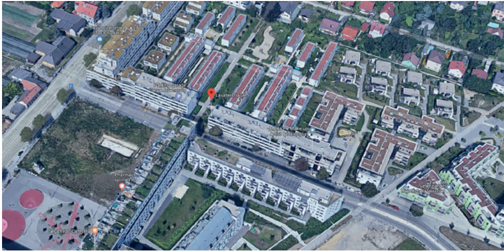
Abbildung 6: Mehrfamilienhaus in der Lavaterstraße 5 mit ca. 70 Wohnungen. Quelle: (Google Maps , 2018)
