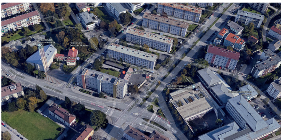
Abbildung 4: Mehrfamilienhaus in der Reichenauer Straße 62, 64 und 66. Quelle (Google Maps, 2018)
