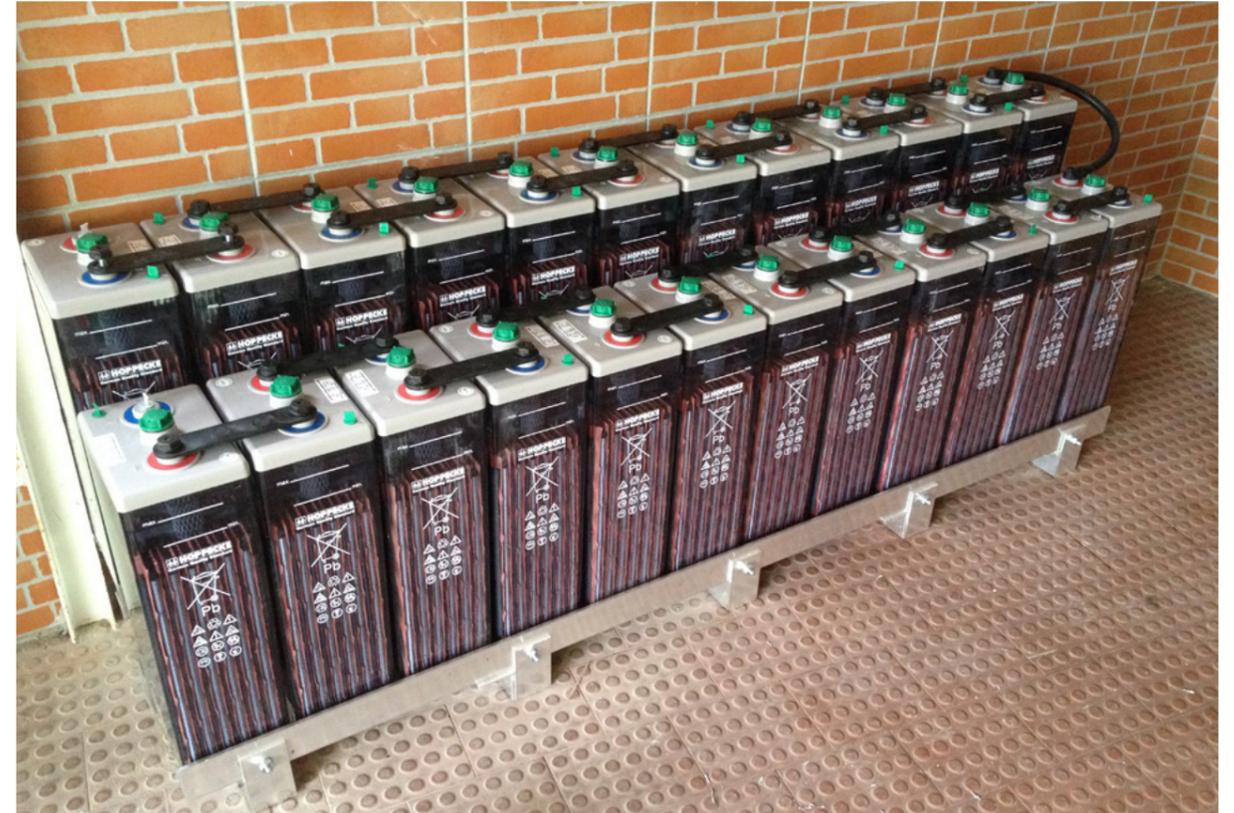
Fig. 5: Banco de baterias de uma UPAC particular de 5000W ligada à RESP na zona do Porto.
